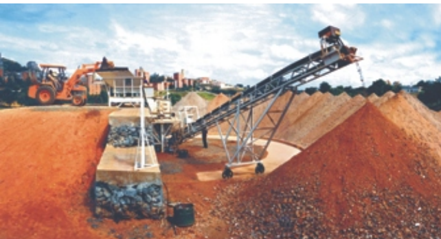
Instalações para reciclagem de RCD (classe A e classe B - madeira)
